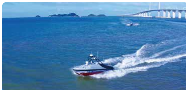
港珠澳大桥巡逻守护
